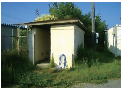
▲改修前の富貴小グラウンドトイレ
