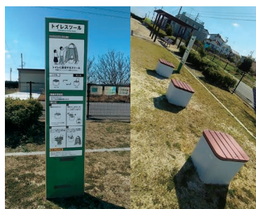
▲マンホールトイレ(祠峯公園)
